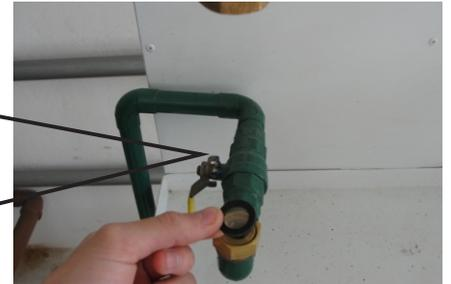
A TP40G3 deve ser instalada de acordo com o seu manual. Acompanhe na Imagem (1) a bomba instalada com adaptadores, e na Imagem(2) a colocação do filtro na entrada de água e acima é colocado um oring para vedação.
